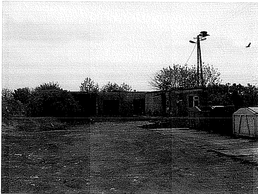
Foto nr 1 Widok budynku socjalnego, garażowego i placu na kontenery do surowców wtórnych.
