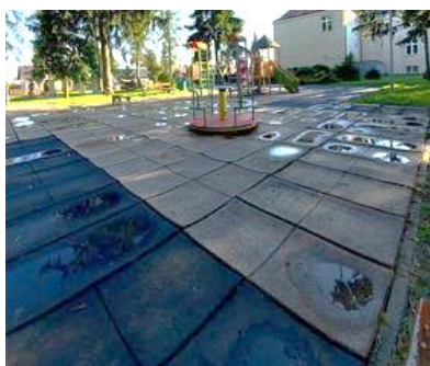
Zdjęcie przed wymianą nawierzchni
